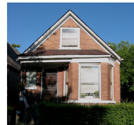
Una casa después del programa de energía – usa menos energía.
